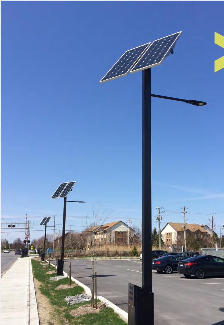
Dans l'un des stationnements de la Ville de Brossard, des panneaux solaires photovoltaïques permettent de créer de l'énergie pour l'éclairage.
